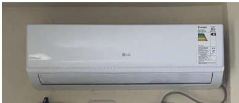
**Figura 3.116** Aire Acondicionado 12000 BTU Alta Eficiencia Dormitorio 1
