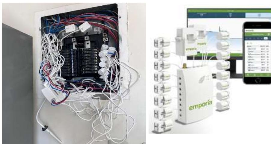
**Figura 2.6** Instalación del medidor Emporia Vue Gen 2
