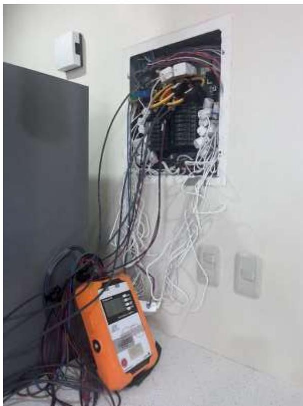
**Figura 2.5** Instalación del analizador de calidad de energía eléctrica PQ-BOX 100
