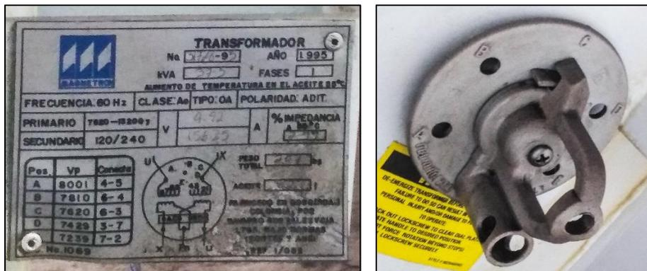
**Ilustración3.3 Datos Transformador en Depósito Aduanero**
