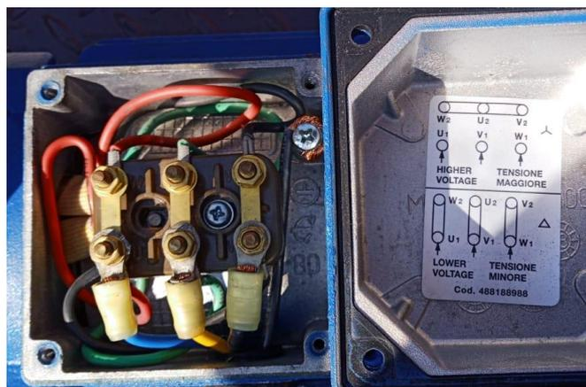
Figura 2.15 Configuración de borneras de la electrobomba
