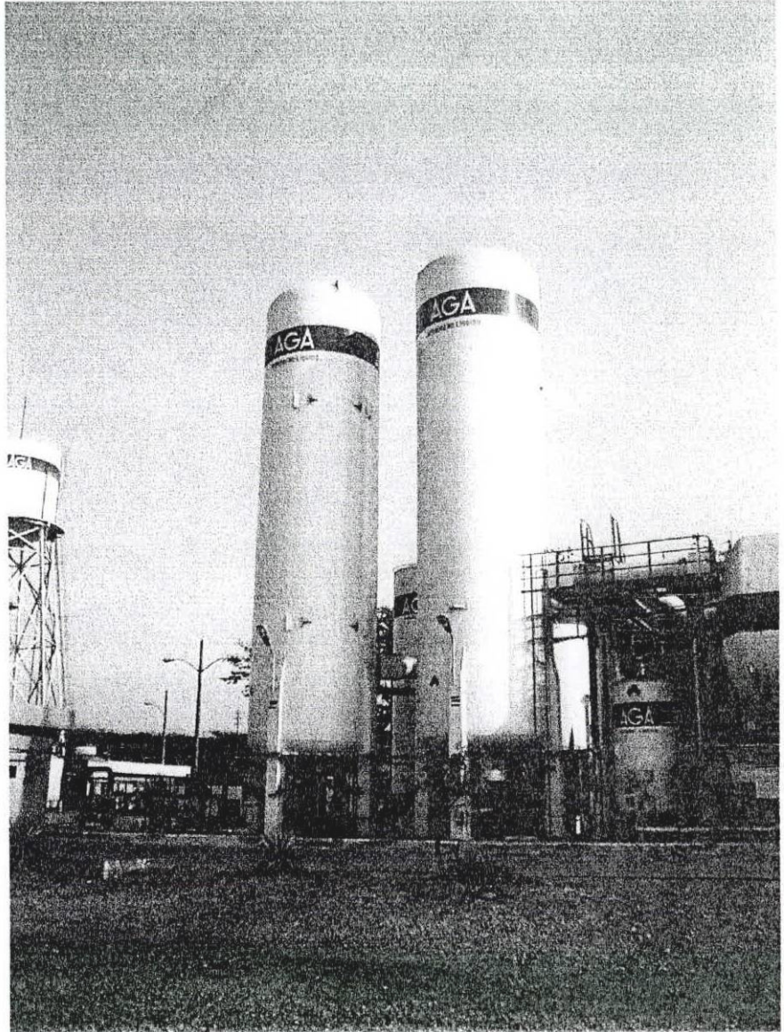
FIGURA 2.11 TANQUES PARA ALMACENAMIENTO DE NITRÓGENO LÍQUIDO
