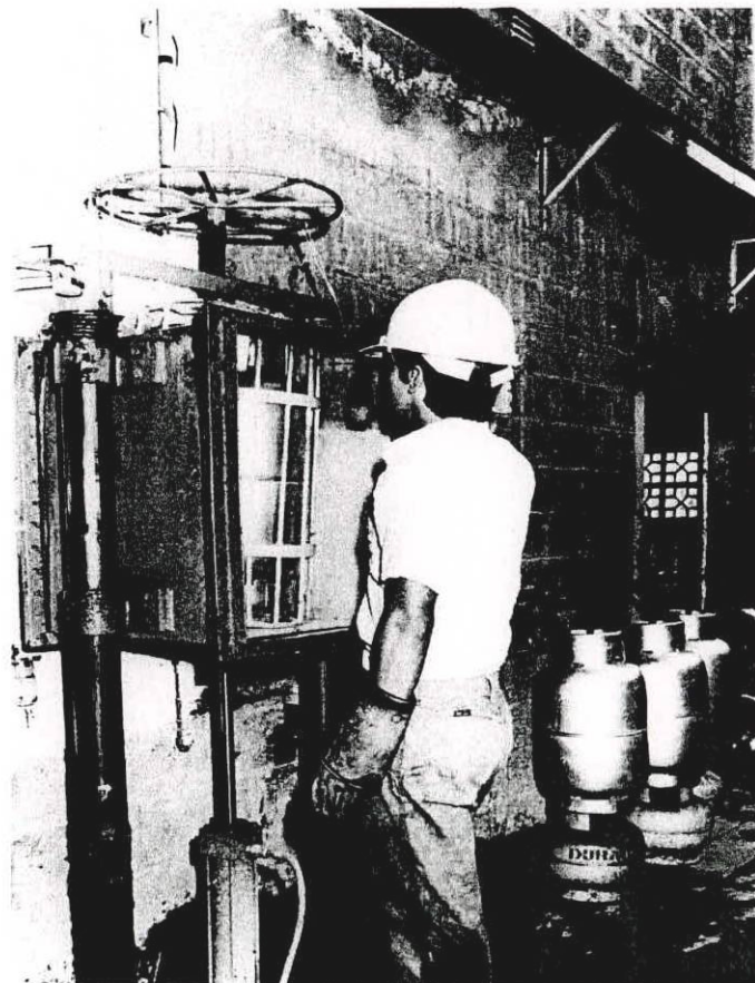
FIGURA 1.10 PRUEBA DE ESTANQUEIDAD
