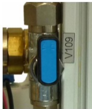
FIGURA 1.6: Válvula manual 3/2 vías
