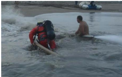
Figura 3. Proceso de aterrizaje del cable submarino
