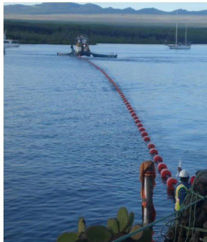
Figura 4. Tendido del cable submarino en el fondo marino
