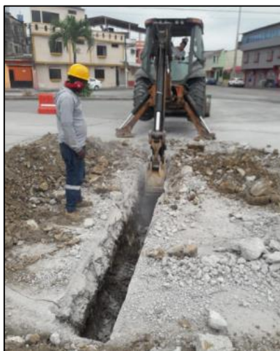
Figura 1.17: Construcción de Zanja cruzando la Calzada [9].
