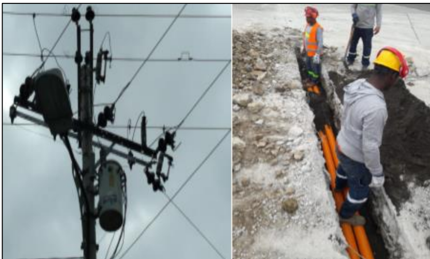
Figura 1.11 Ejemplos entre Acometida Aérea y Acometida Subterránea [9]
