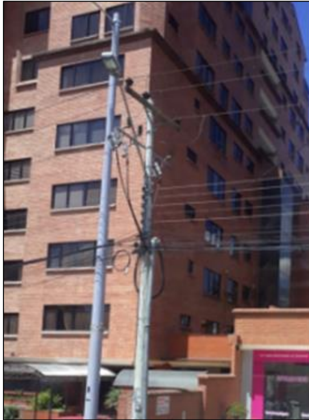
Figura 2.19 Poste con acometida Subterránea.
