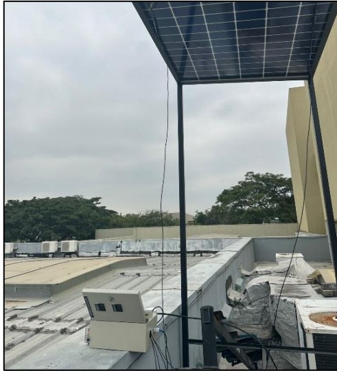
Figura 2.22 Conexión con el módulo bifacial
