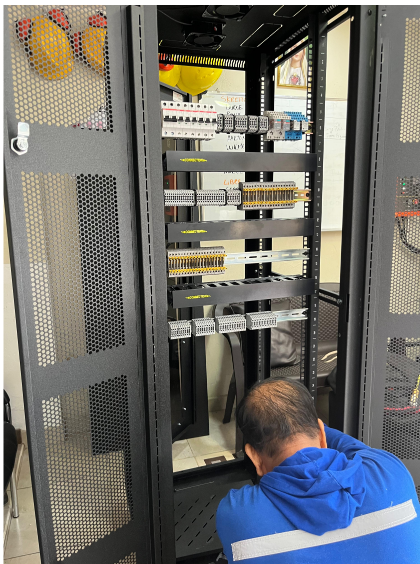
Figura 1: Montaje de elementos eléctricos en tablero
