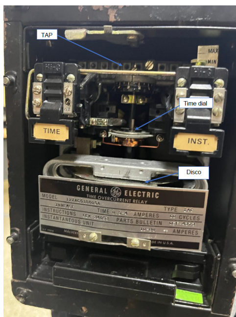
Figura 1.6: Ejemplo de relé electromecánico para protección de sobrecorriente
