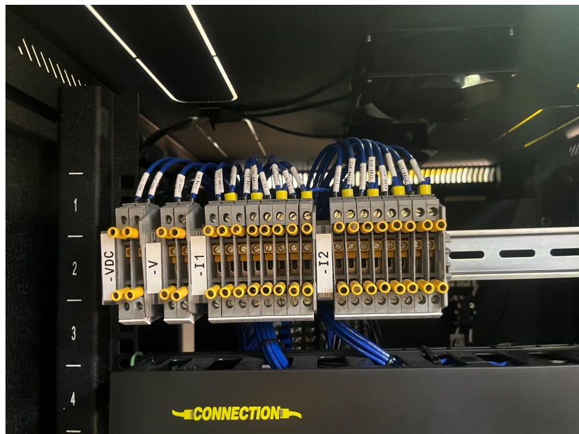
Figura 3.6: Borneras con terminales de prueba para entradas analógicas
