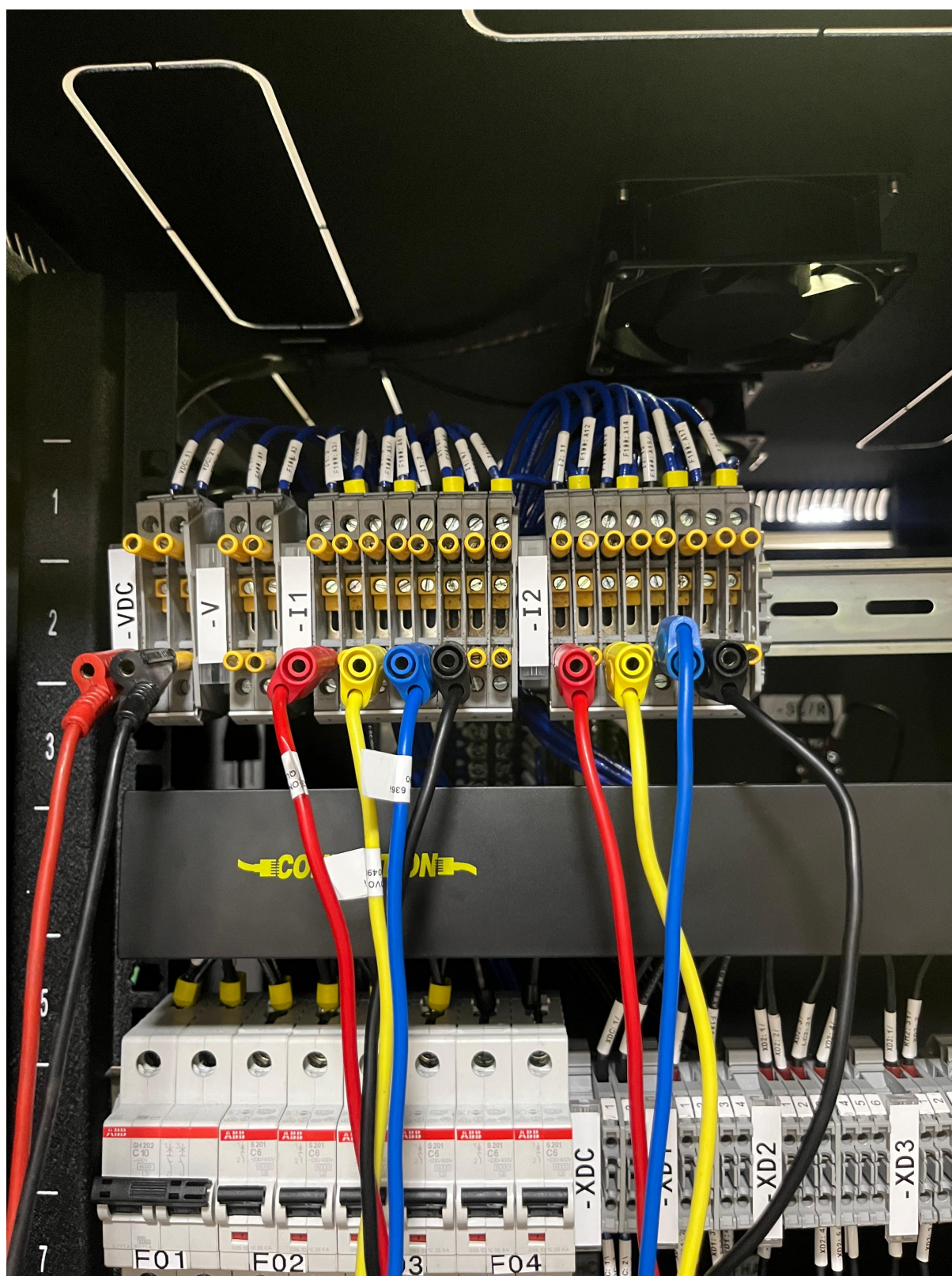
Figura 4: Realización de pruebas de inyección
