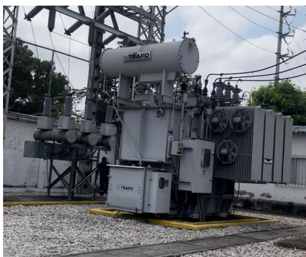
Figura 1.9: Transformador de potencia de 69 kV
