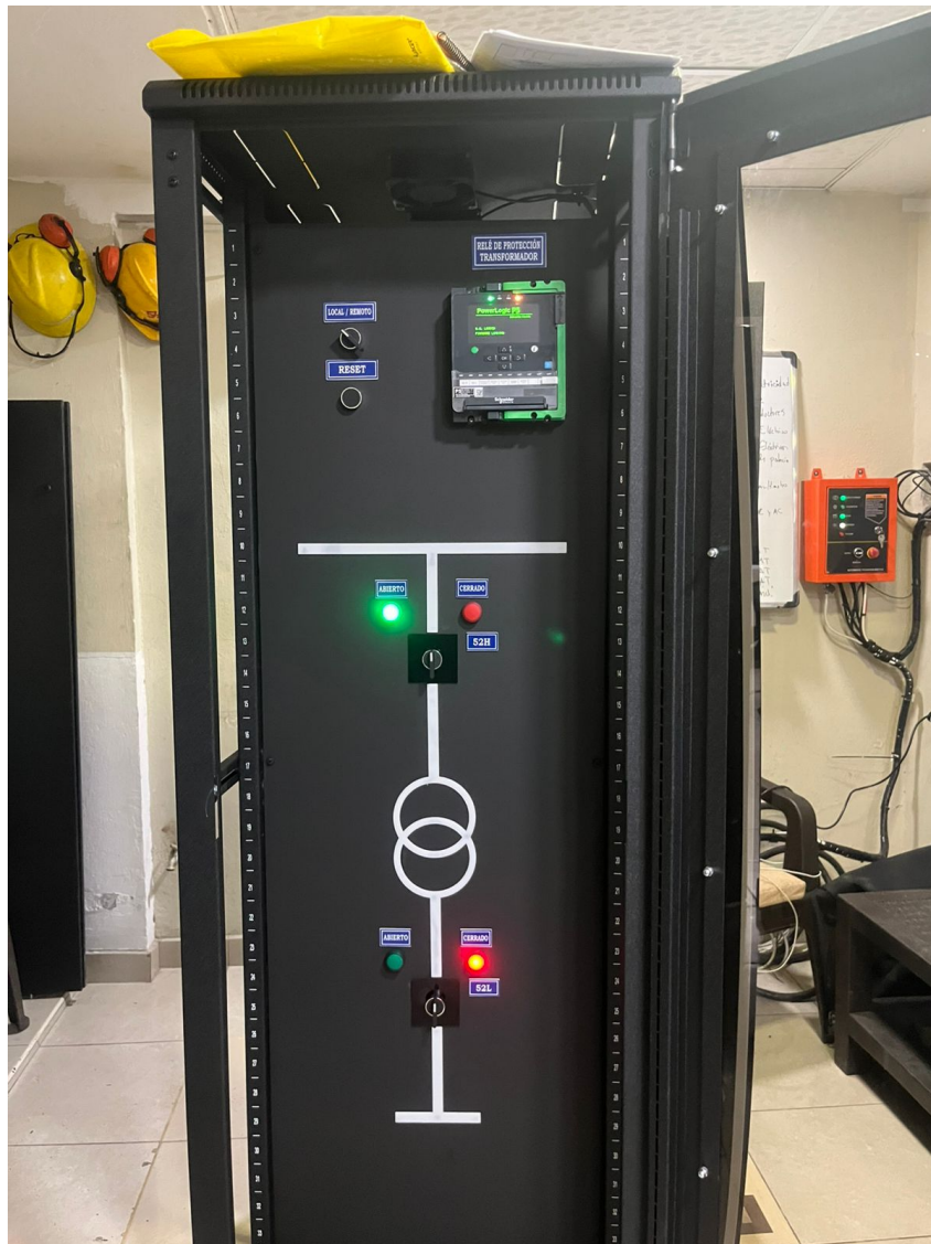
Figura 2.28: Construcción del tablero de protecciones tipo rack
