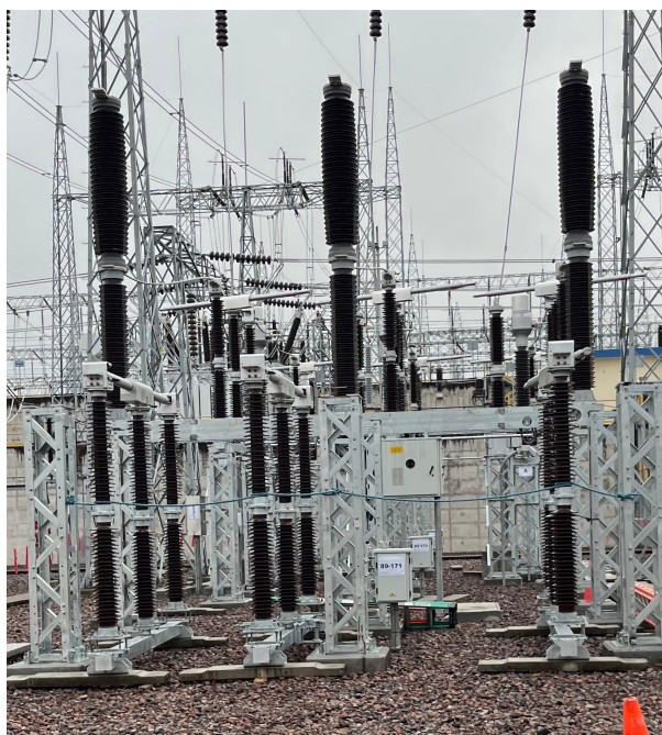
Figura 1.8: Interruptor de potencia de 230 kV
