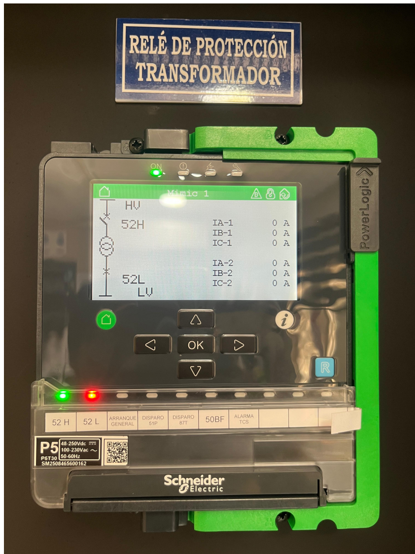
Figura 3.8: Relé de transformador Schneider electric modelo P5T30
