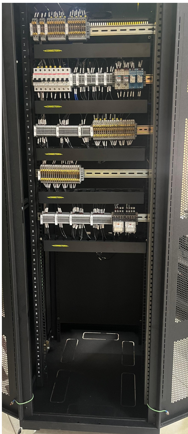
Figura 3.4: Tablero didáctico de protecciones vista posterior de conexiones
