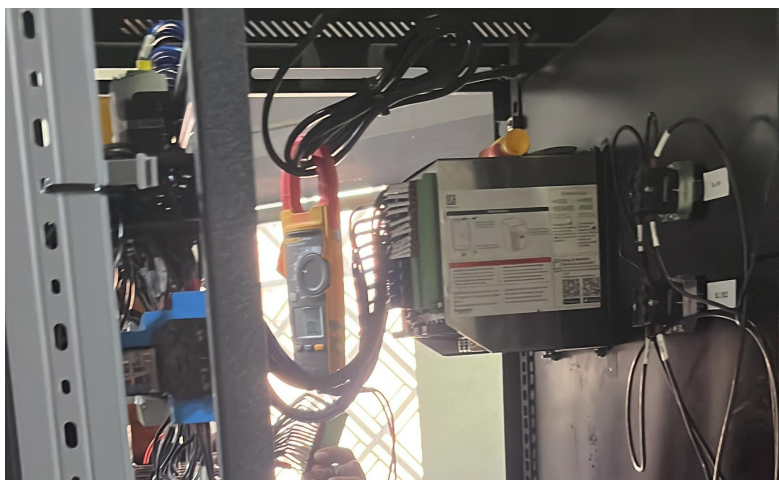
Figura 2.30: Cableado del tablero con el relé
