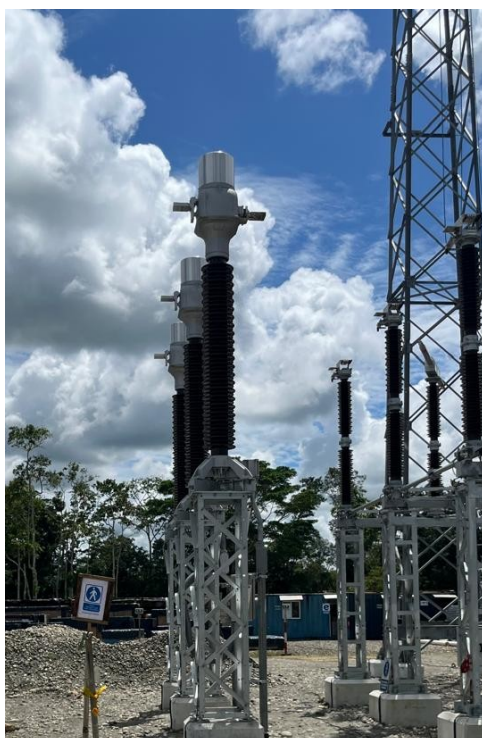
Figura 1.3: Transformador de corriente de 230 kV
