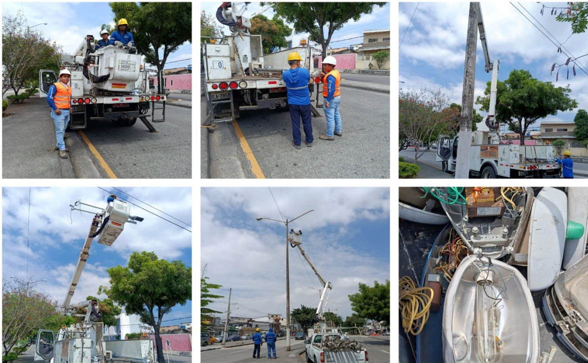
Reemplazo de luminarias de sodio por luminarias led en Avenida Isidro Ayora
