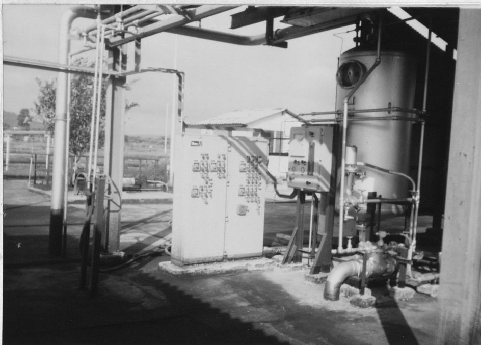
Foto # 8.- Panel de Control y tanque de Presurización.
