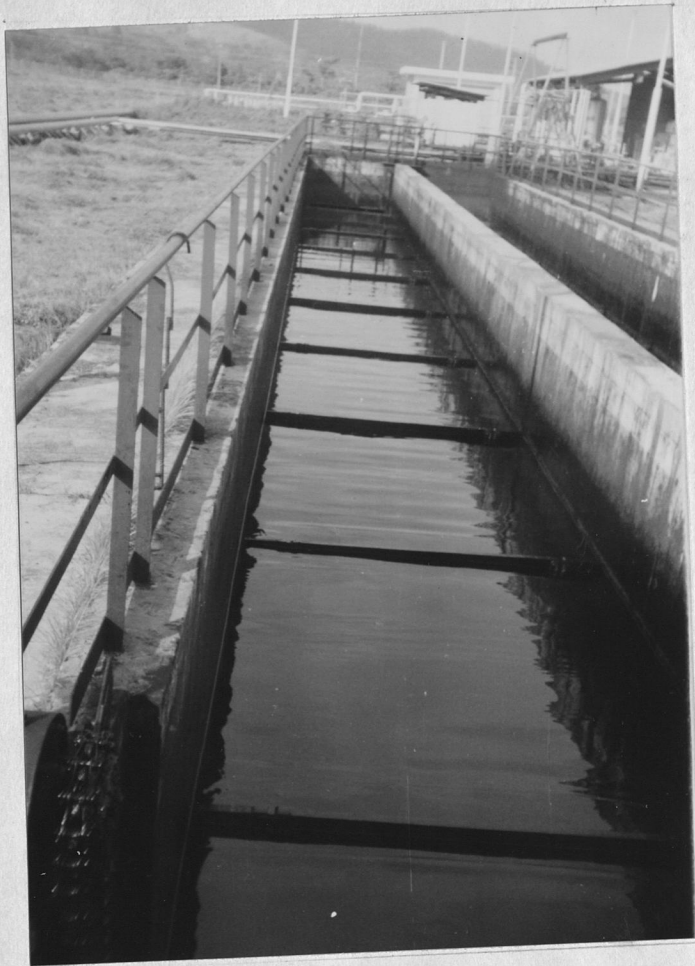
Foto. # 3 Separador API "A" Operando.
