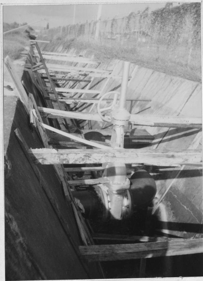
Foto # 9 Salida de agua del cuello de ganso al canal SUR.
