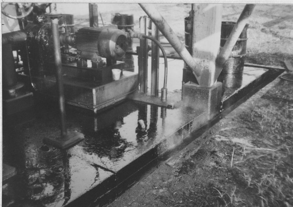
Foto# 7.- Derrame Fuel-oil en la Sección SETIL.
