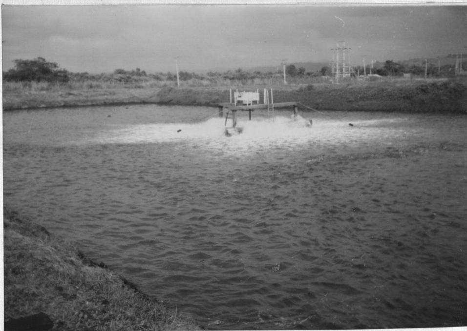
Foto # 5.- Piscina de Aireación. AIREADOR Y-ME 6006 B OPERANDO.
