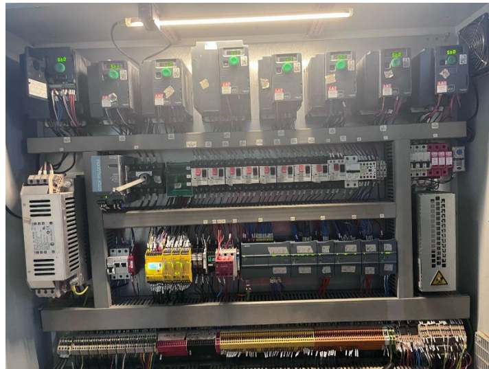
Figura # 11. PLC y nuevos módulos una vez realizada la reingeniería.
