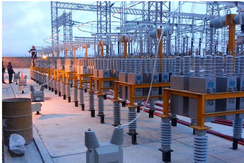
Figura 2.11: Banco de Capacitores en una subestación. Fuente: DIRAM [5].
