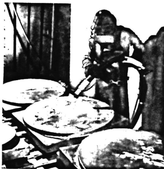
Fig. N° 10.- Soplado con perdigones, en un recinto especial.
