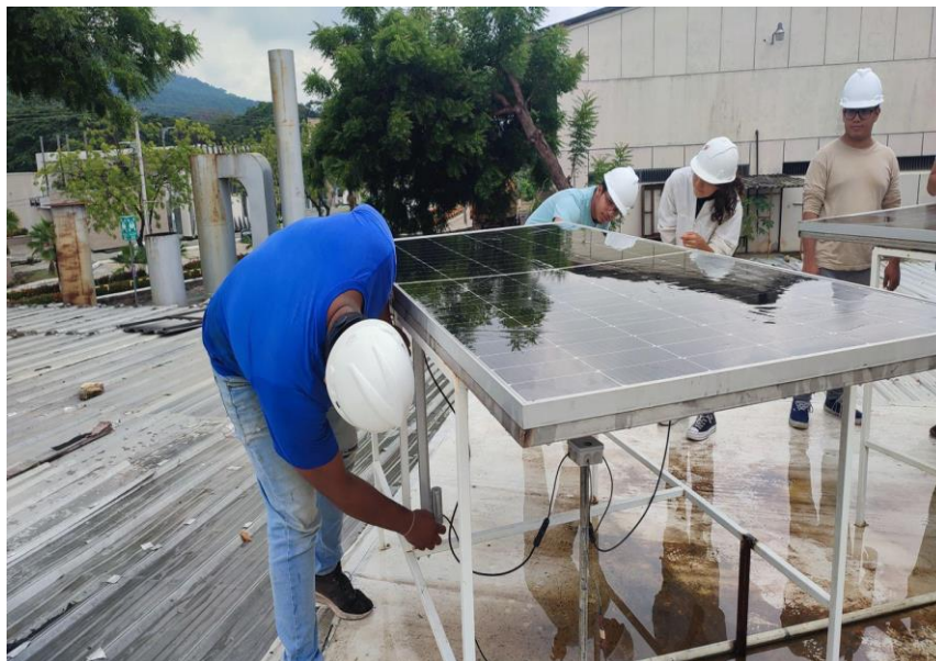
Figura 4. 16 Instalación de Paneles Solares Fotovoltaicos Bifaciales en el campus CDTs de ESPOL
