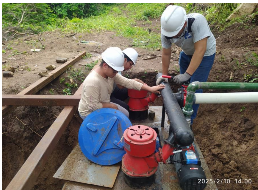
Figura 4. 21 conexión de tuberías al colector
