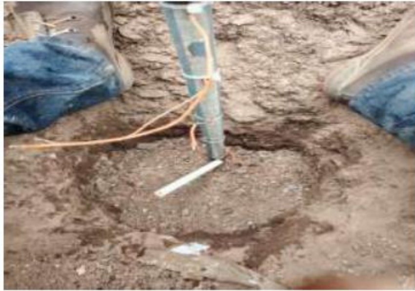
Figura 4. 19 Instalación de sensores de flujo de aire
