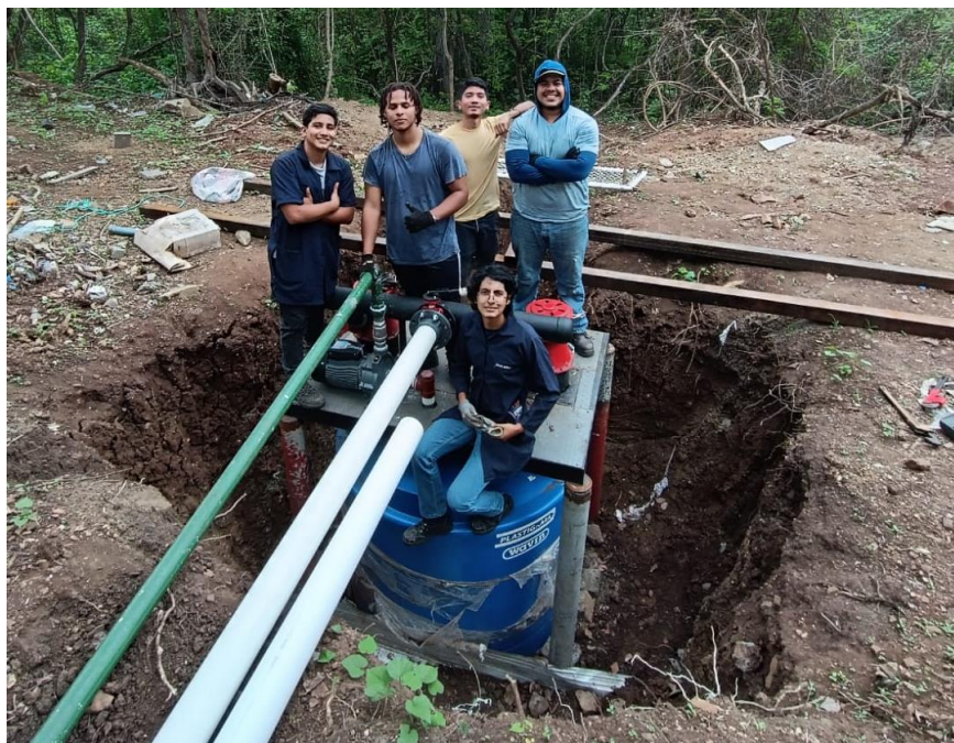
Figura 4. 20 Montaje estructural de la planta piloto
