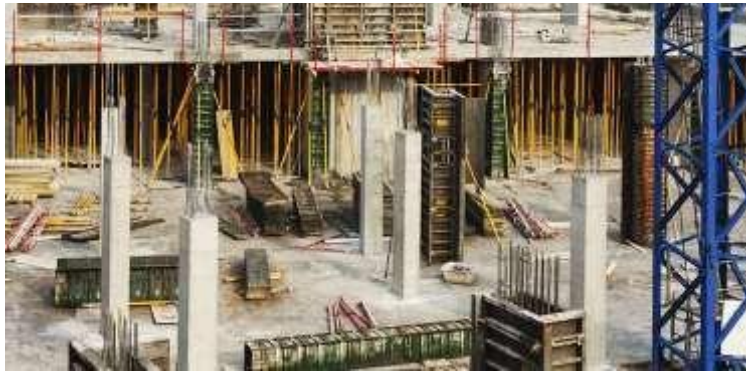
Figura 8: Estructura de hormigón armado
