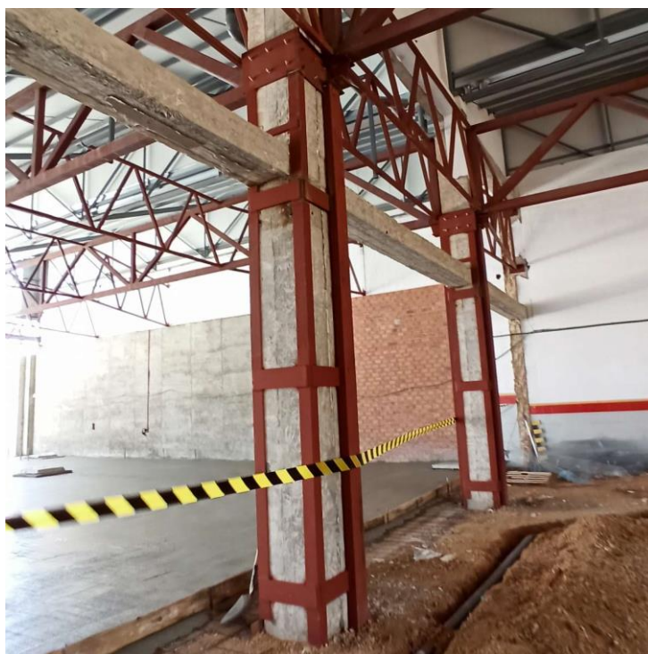
Figura 2-10 Refuerzo de pilares con perfiles de acero en una estructura histórica. Fuente: (IFITEC, n.d.).
