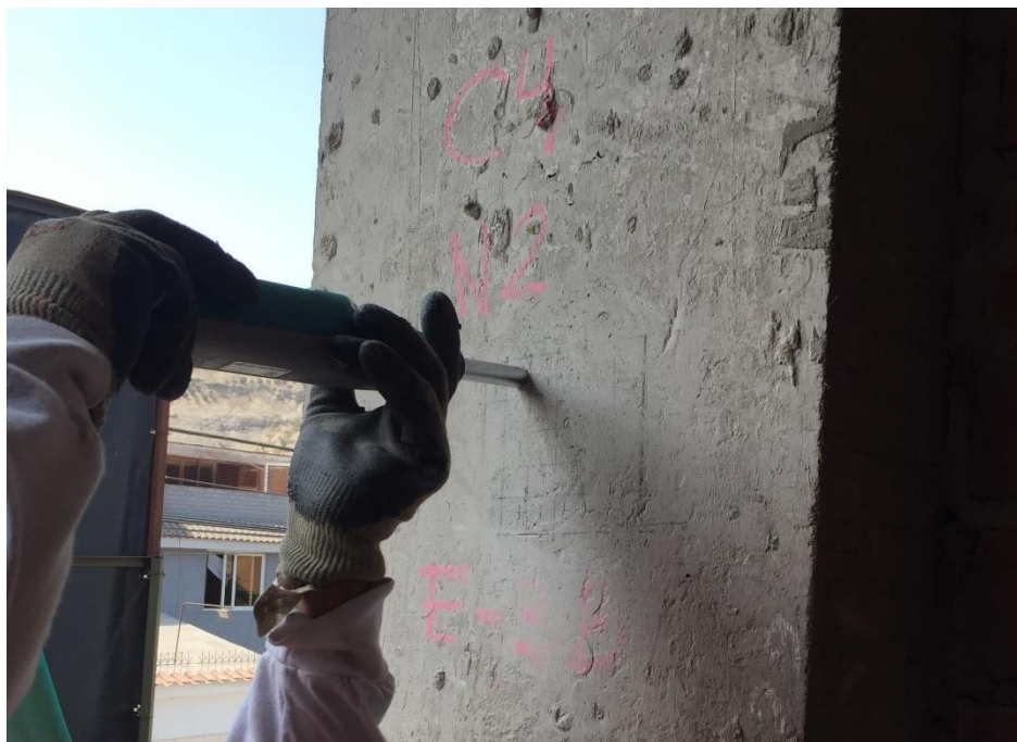
Figura 2-16: Aplicación de ensayos no destructivos en una estructura de concreto.
