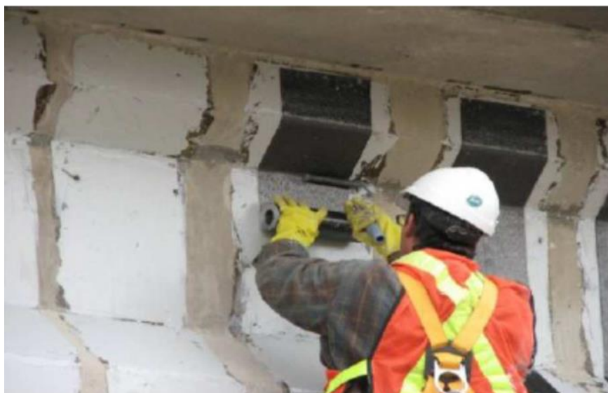
Figura 2-9 Aplicación de Refuerzo Estructural con Fibra de Carbono en Elementos de Hormigón. Fuente: (Ružić & Zahirović, 2022).
