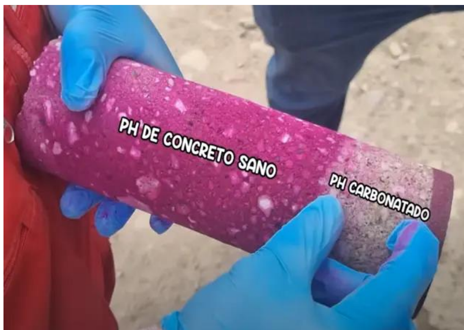
Figura 2-21: Ensayo de carbonatación del concreto. Fuente: (Construneic, 2024).
