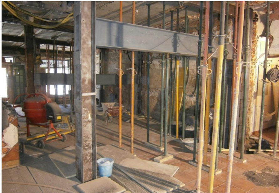
Figura 2-7: Rehabilitación de estructura metálica en edificio de once plantas. Fuente: (LCDV arquitectos, 2024).
