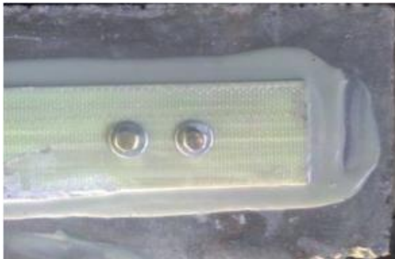
Figura 2-11: Refuerzo de fisuras en concreto mediante adhesivo epóxico y anclaje mecánico.
