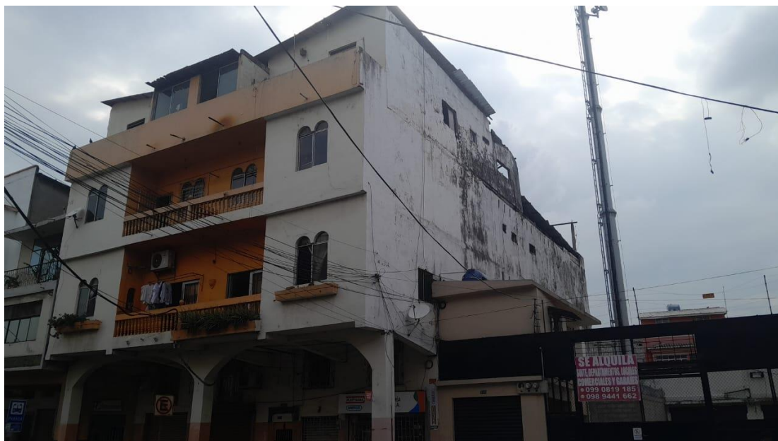
Figura 1-2 Figura del edificio analizado.
