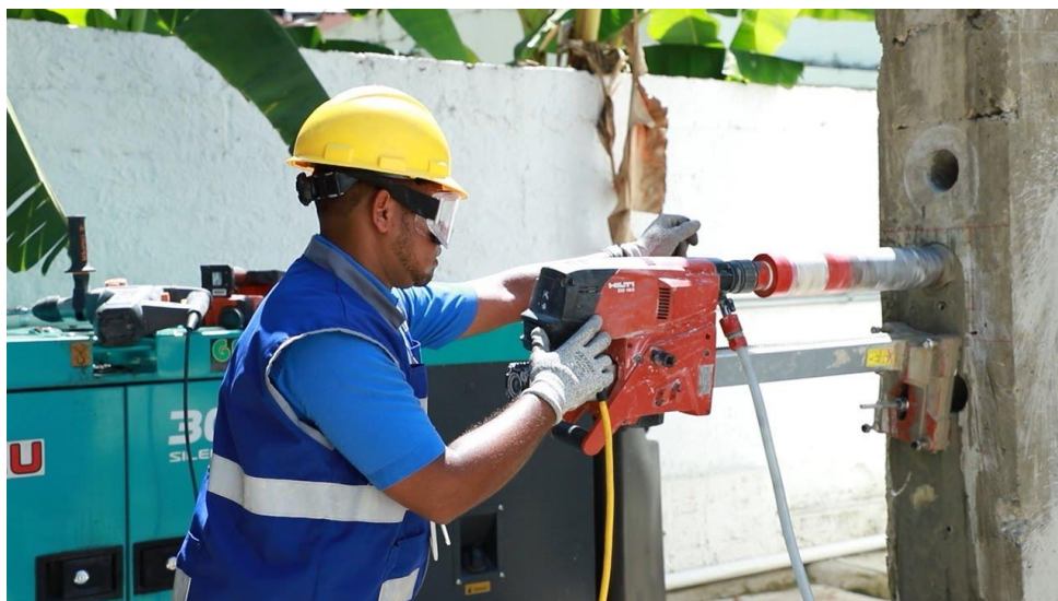
Figura 2-20: Proceso de extracción de núcleos de hormigón. Fuente: (Onesvie RD, n.d.).
