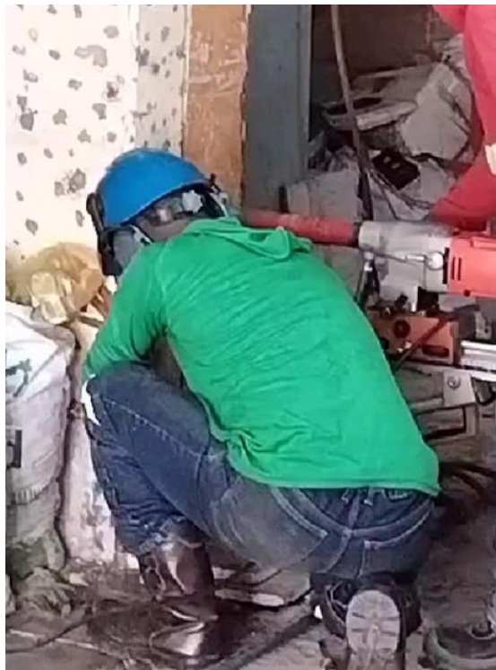
Figura 3-1: Extracción de núcleos
