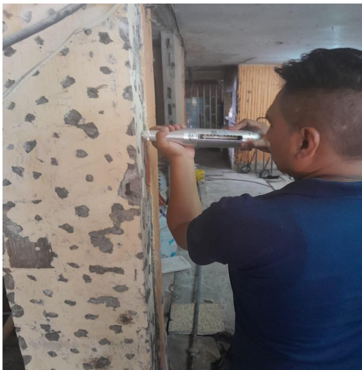
Figura 3-2: Aplicación del ensayo de esclerometría
