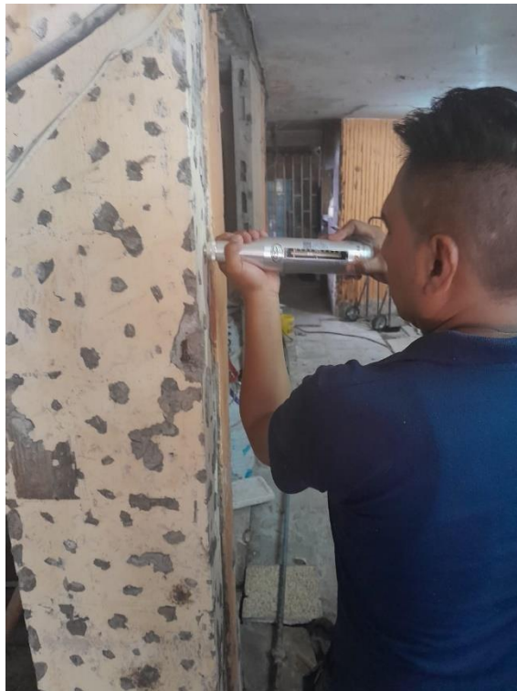
Figura 2-24: Ensayo de esclerometría aplicado en columna
