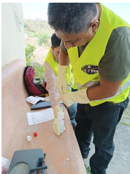
Figura 2-28: La imagen muestra aplicación de fenolftaleína, un indicador de pH que permite identificar visualmente las áreas carbonatadas.
