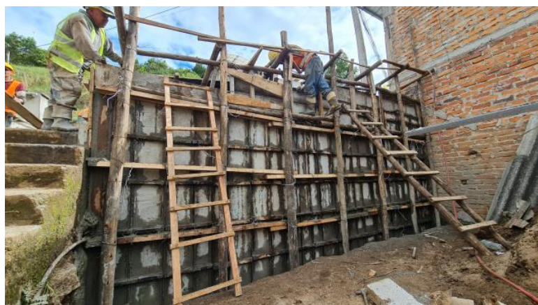
Gráfico 2.13 Uso de encofrado metálico para fomentar la reutilización de materiales.
