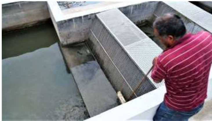
Figura 1. Limpieza de rejillas
