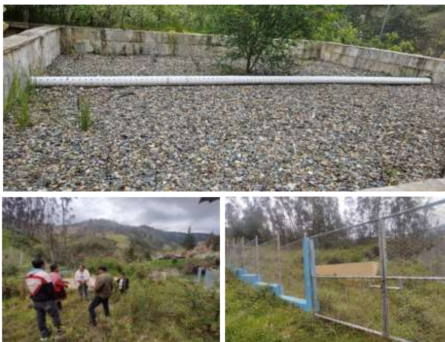
Figura 3.1 Estado inicial de la PTAR
