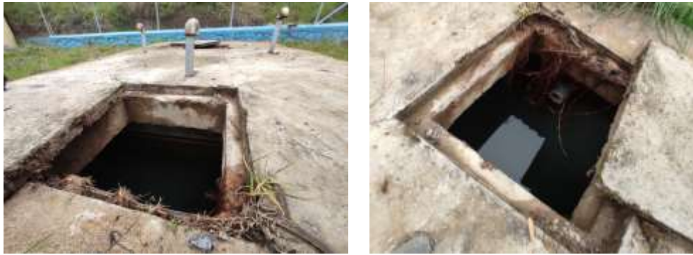
Figura 3.3 Fosa séptica sin cota de funcionamiento
