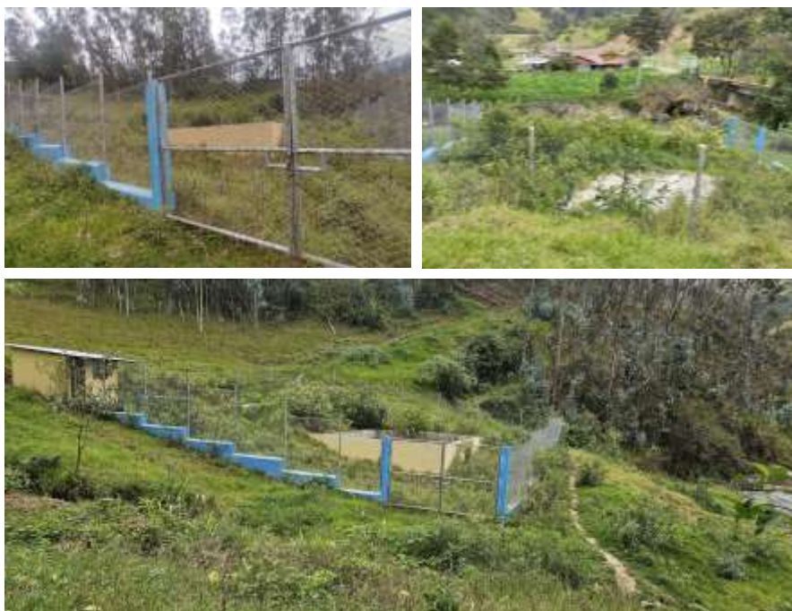
Figura 1.3 Estado inicial PTAR San Pedro
