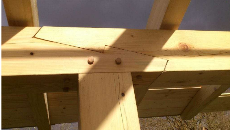
Figura 2.6: Ensamblajes a rayo de júpiter
