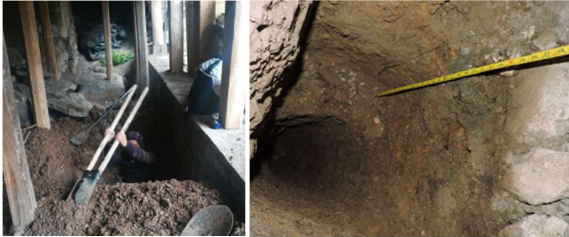
Figura 2.12: Excavación de primera calicata [23]
