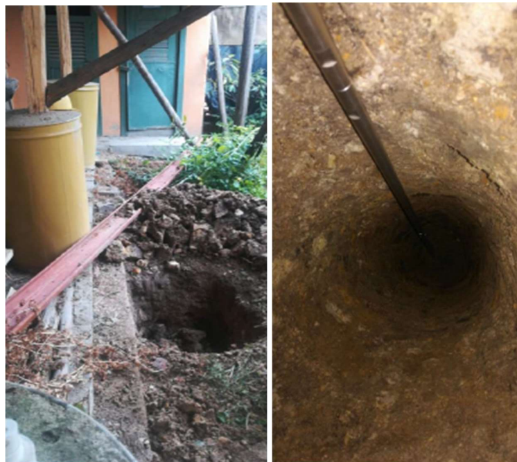
Figura 2.13: Excavación de segunda calicata [23]
