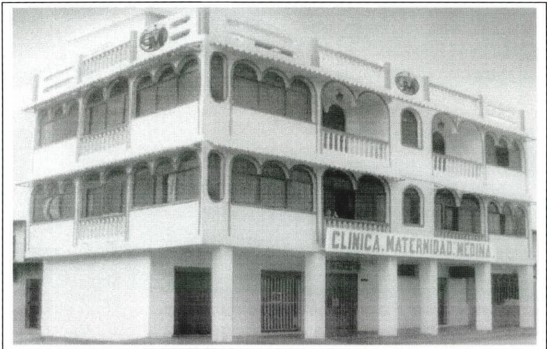
Figura 2. Clínica después de remodelaciones
