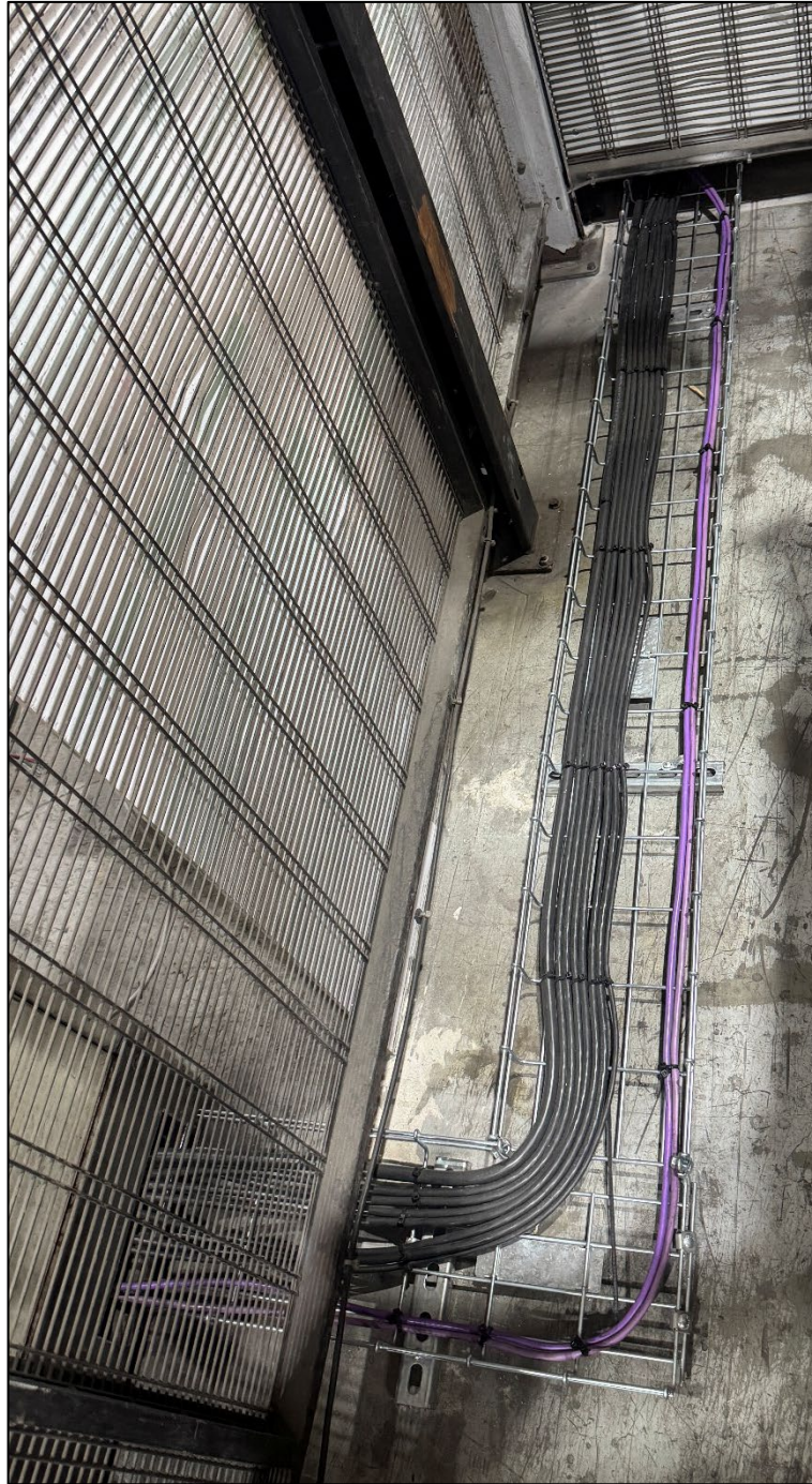
Fig. 3.4 Conexión entre tableros.
