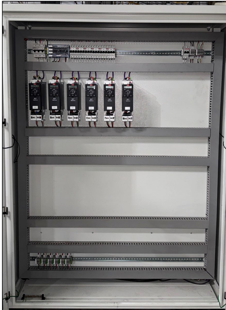
Fig. 3.2 Tablero vista interior.
