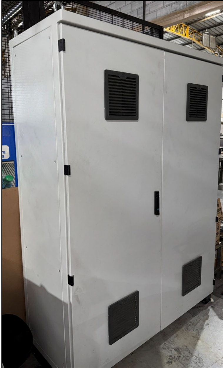
Fig. 3.3 Tablero vista exterior.
