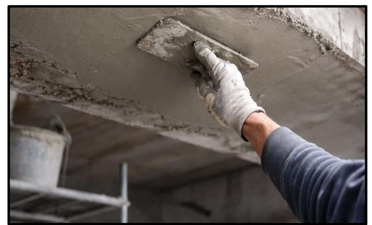
Capa de recubrimiento de mortero nuevo de 30mm en losa
