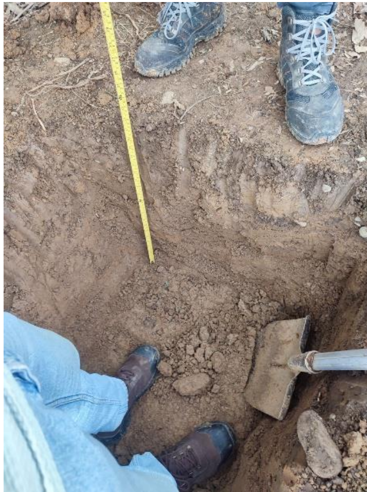
Figura 9. Calicata # 1 con 1 metro de profundidad
