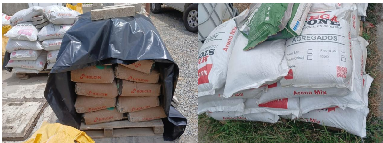
Figura 2.10 Acopio de materiales (cemento, agregado grueso, agregado fino, fibras)
