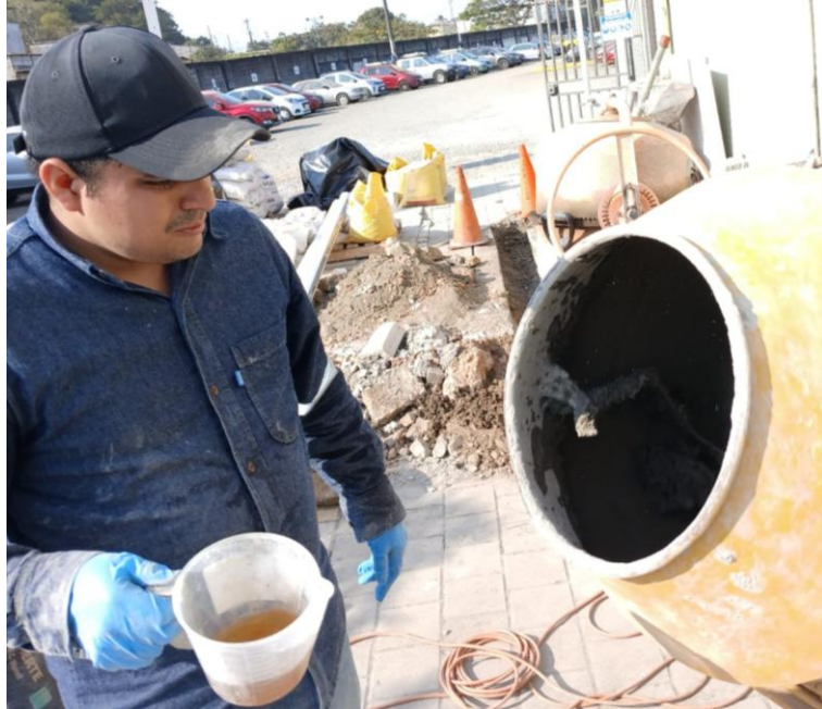
Figura 2.26 Incorporación del superplastificante
