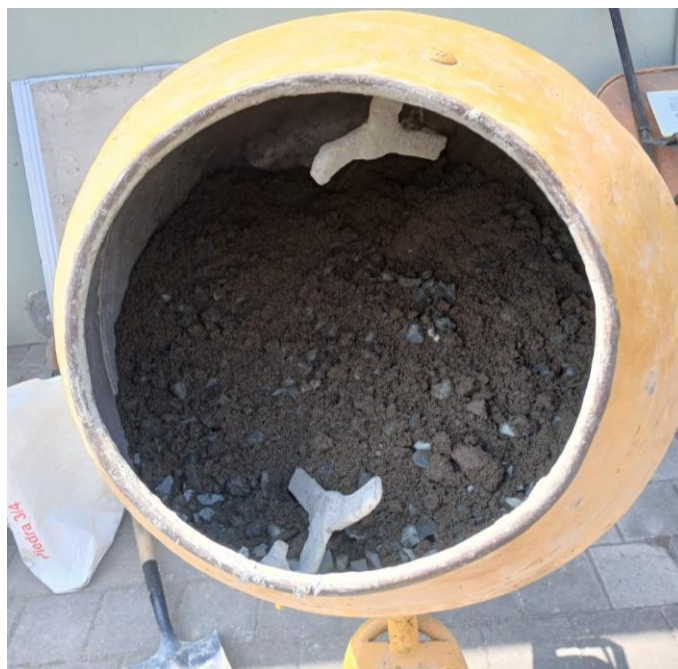
Figura 2.23 Incorporación de agua a los agregados
