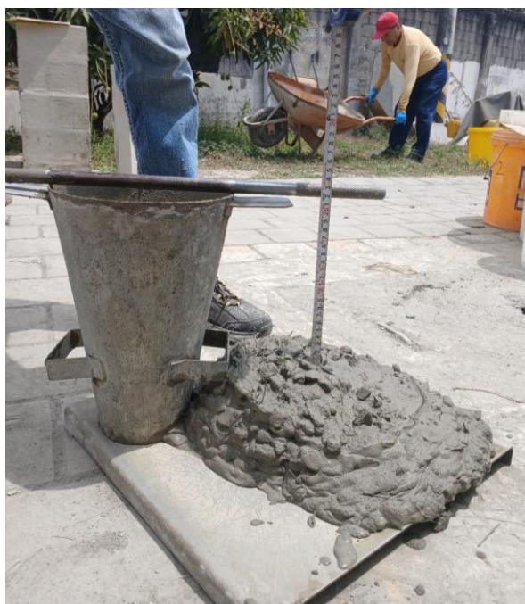
Figura 2.44 Medición del asentamiento
