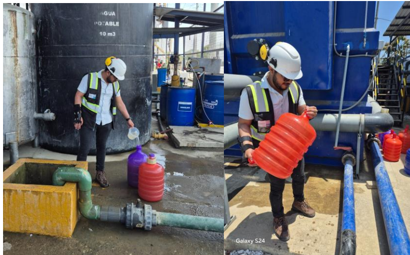
Figura 8: (a) Punto de muestreo de la captación. (b) Punto de muestreo a la salida del filtro
