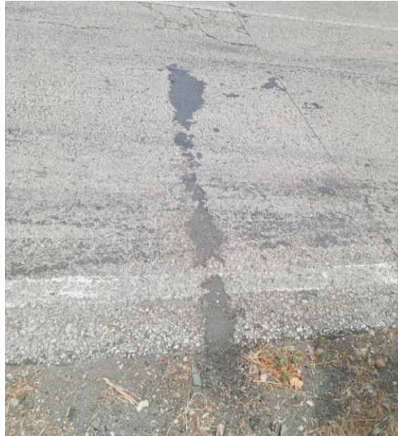
Figura 3.15 Reparación parcial de losa realizada al interior del campus. 9 de 10.
