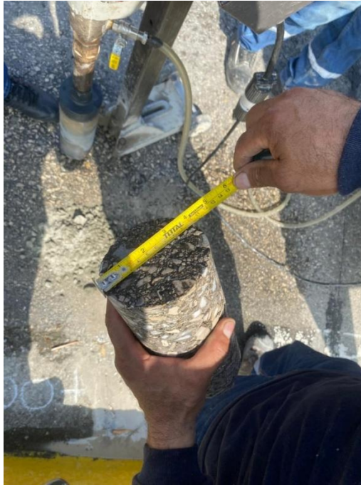
Figura 2.24 Núcleo de hormigón extraído (abscisa 1+460)
