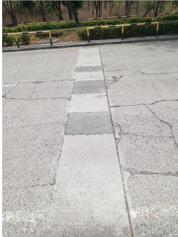
Figura 3.13 Reparación parcial de losa realizada al interior del campus. 7 de 10.
