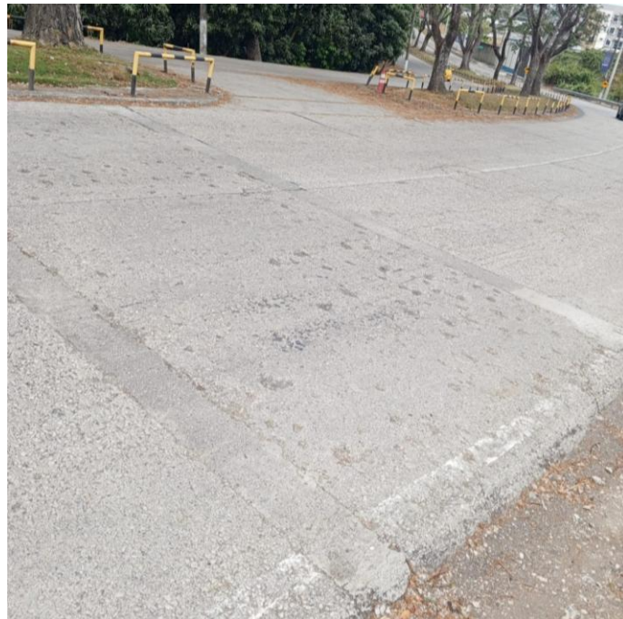
Figura 3.9 Reparación parcial de losa realizada al interior del campus. 3 de 10.
