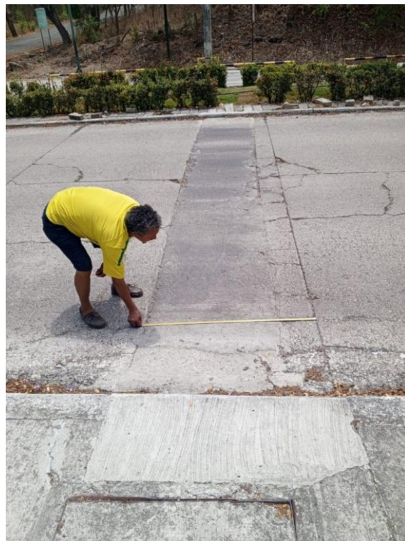
Figura 3.14 Reparación parcial de losa realizada al interior del campus. 8 de 10.
