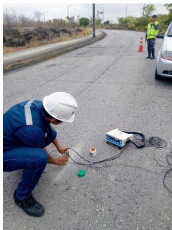
Figura 2.30 Ensayo de Ultrasonido en fisura transversal (Abscisa 1+163)
