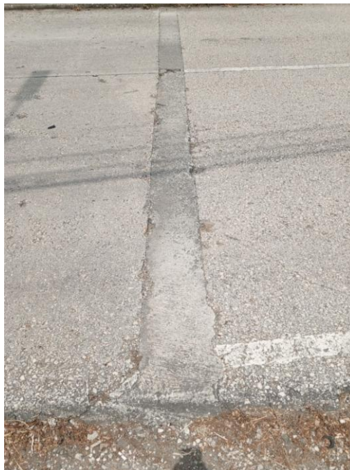
Figura 3.10 Reparación parcial de losa realizada al interior del campus. 4 de 10.
