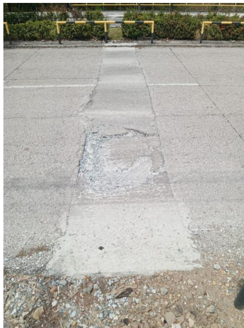
Figura 3.12 Reparación parcial de losa realizada al interior del campus. 6 de 10.
