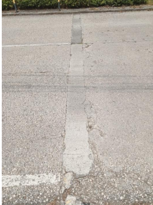
Figura 3.11 Reparación parcial de losa realizada al interior del campus. 5 de 10.
