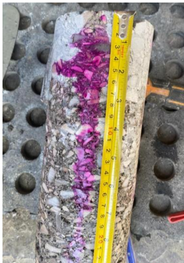
Figura 3.1 Oquedades en el hormigón (abscisa 0+724)
