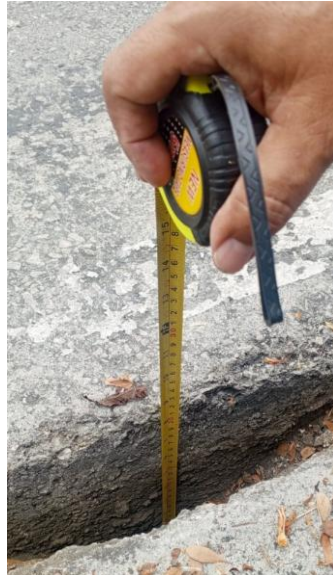
Figura 2.20 Medición directa de espesor de losa (abscisa 0+302)
