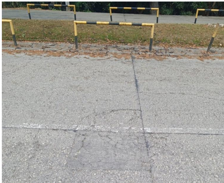
Figura 3.16 Reparación parcial de losa realizada al interior del campus. 10 de 10.
