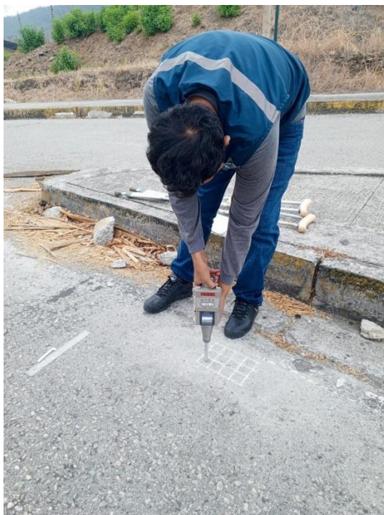
Figura 2.22 Toma de lecturas con esclerómetro
