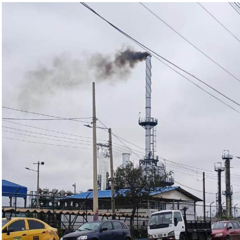
Figura 9 Emisiones visibles de un horno de proceso en operación en la Refinería La Libertad
