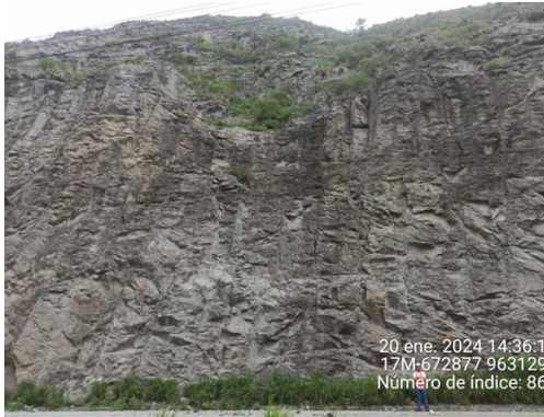
g. Vista general de Talud Estación
