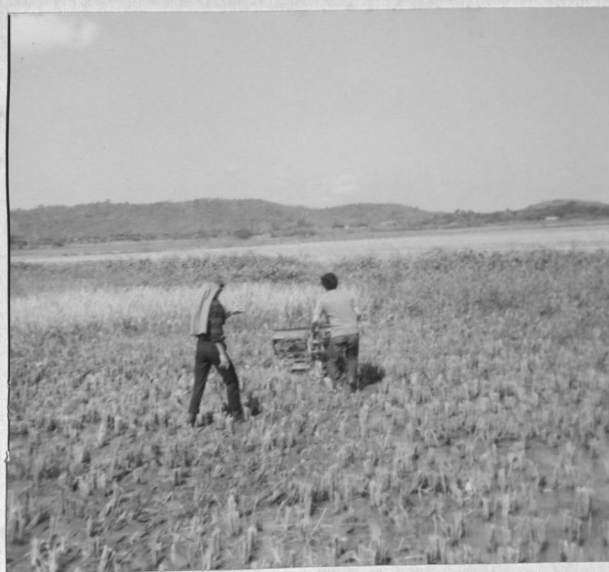
Foto # 18 SEGUNDA PRUEBA DEL MOTOCULTOR EN TERRENO FANGOSO
