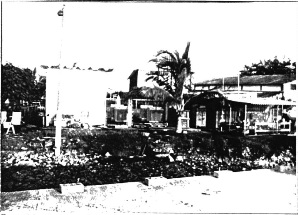
Estación de transformadores detrás de los contenedores
