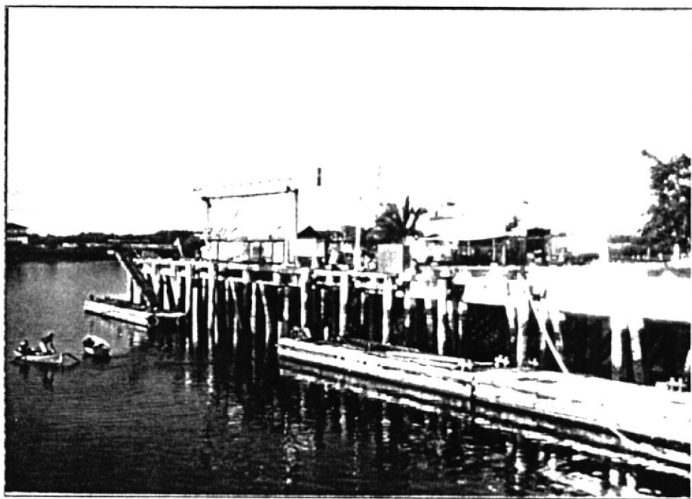
Vista exterior del muelle de Submarinos. Las tomas para las mangueras, estarán ubicadas a la derecha del armario verde que está al lado de la grúa
