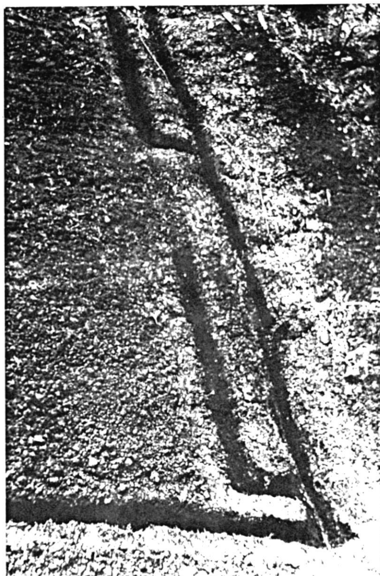
fig. 2.5 Vista de la zanja para el tendido de la tubería secundaria para el tomate y pimiento.
