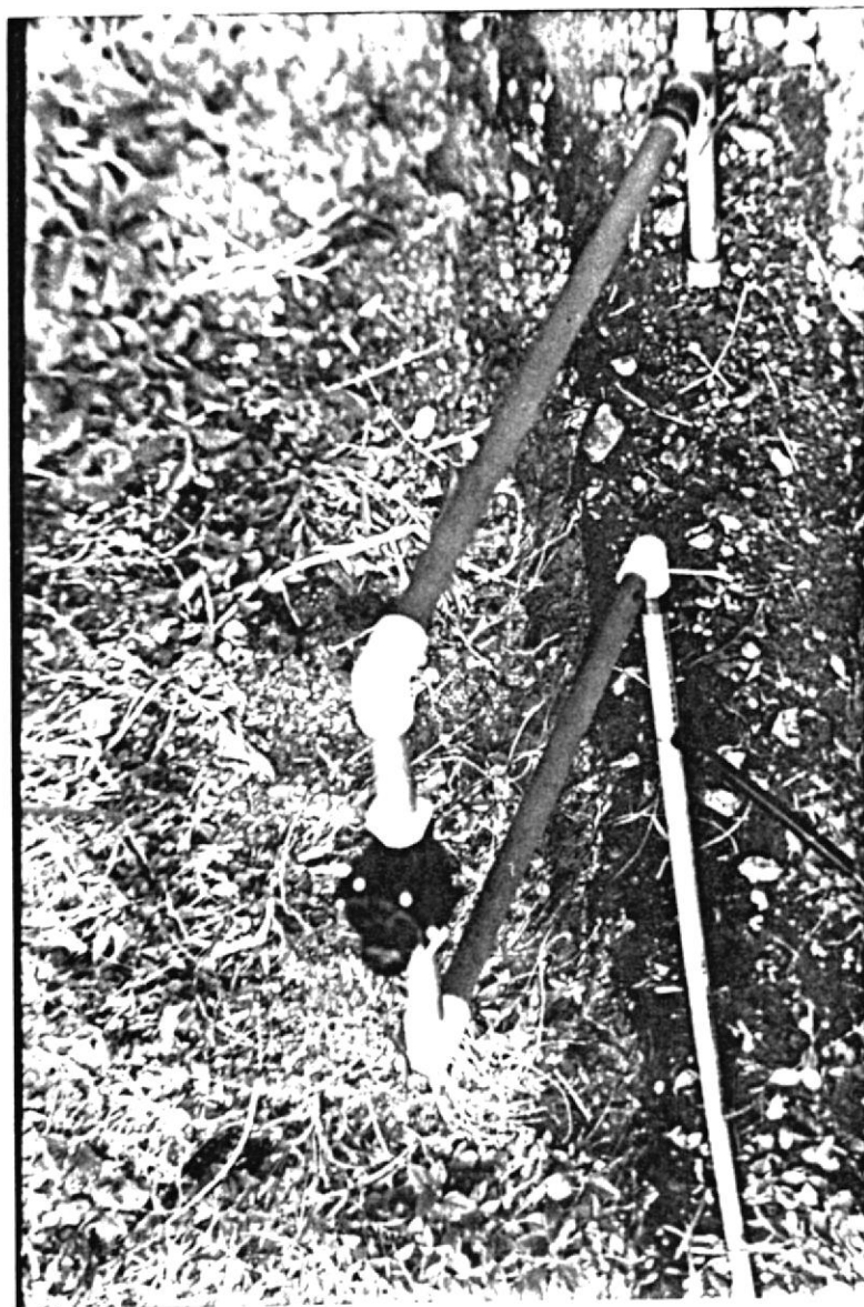
fig. 2.10 Instalación de tubería secundaria, codo, reductor buje, válvula solenoide para la parcela de pimiento.
