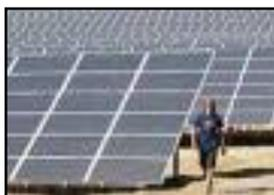
Para conseguir producir energía solar fotovoltaica, en primer lugar lo que nos hace falta es un conjunto de paneles solares fotovoltaicos conectados entre si mediante un cableado, con soporte o sin soporte, la energía eléctrica que se produce es una energía eléctrica continua, esta energía en este estado no puede ser inyectada a la red convencional para ello nos hará falta un inversor que convertirá la energía eléctrica producida por la energía
