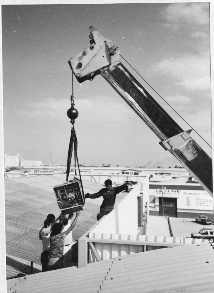
Figura # 3 Colocación del compresor de 25 HP en "Mi Comisariato" de Domingo Comín.
