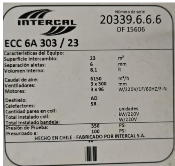
Figura 43 Placa de evaporador de cámara de media temperatura.
