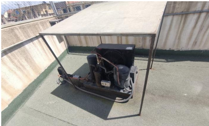
Figura 19 Antiguas unidad condensadoras de expansión directa de baja temperatura para cámara de congelados.
