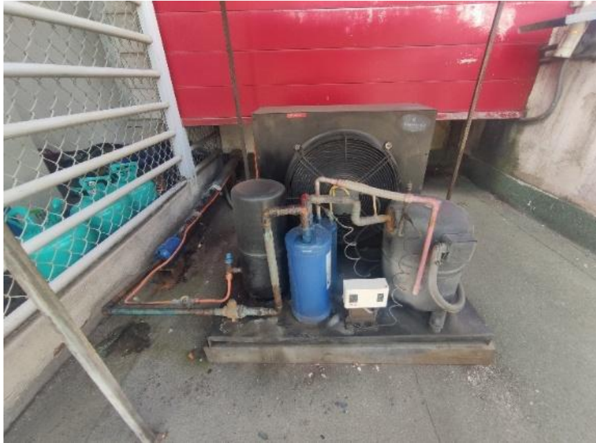
Figura 19 Antiguas unidad condensadoras de expansión directa de baja temperatura para cámara de congelados.
