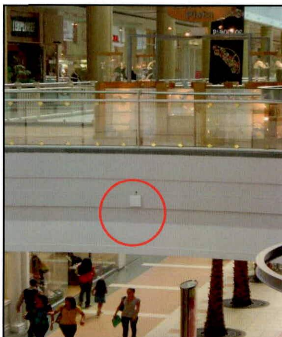
Figura 6 Antena tipo panel instalada en un centro comercial
