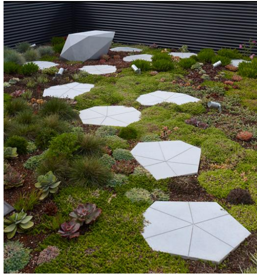
Figura 12. Cubierta verde Semi-intensiva, proyecto Casa Galería / Ogrydziak Prillinger Architects
