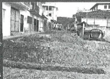
Obras hidrosanitarias en el Centro Cantonal
