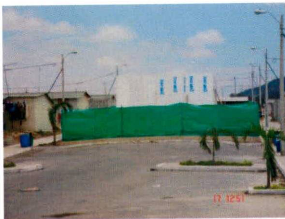
Foto 5.- Construcción de una Unida Policial Comunitaria
