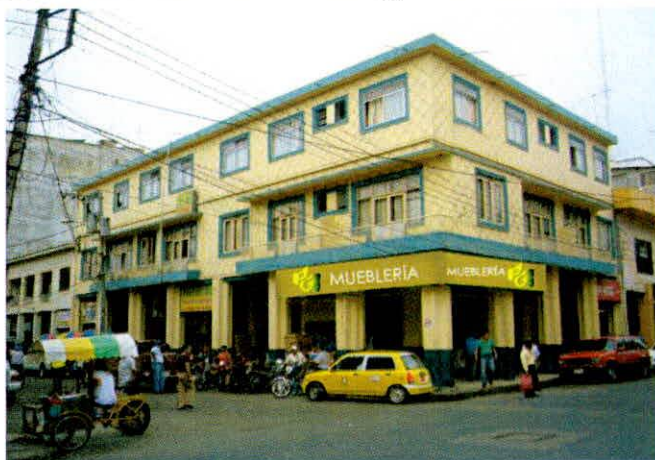
Figura 5. Fachada externa mueblería
