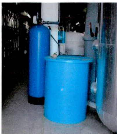
FIGURA 2.3: CONTROL DE TEMPERATURA
