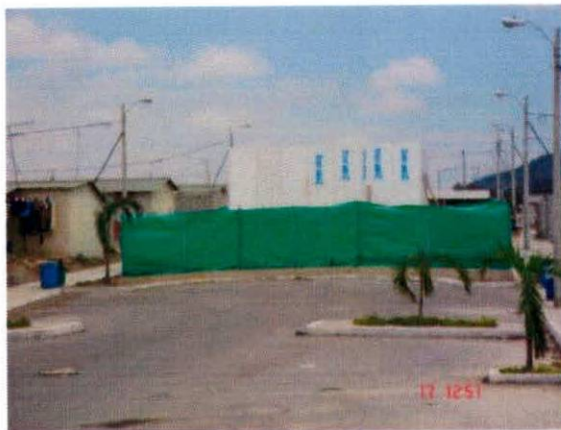
Foto 5.- Construcción de una Unida Policial Comunitaria
