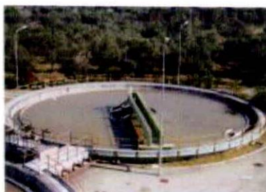
Gráfica 8.9 Planta de tratamiento de aguas residuales. Fuente: SERECO, Italia, equipos tratamiento de aguas.
