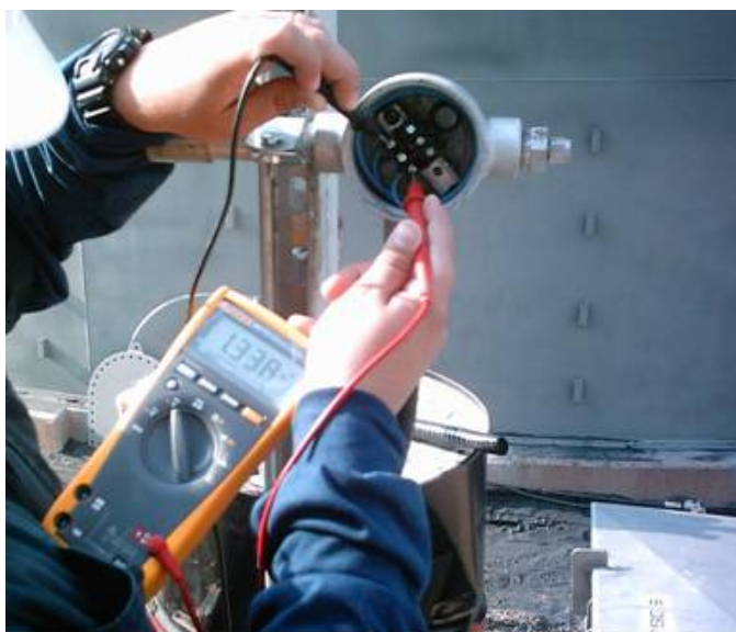
FIGURA 3.6 MEDICION DEL POTENCIAL DE POLARIZACION EN EL CENTRO DEL FONDO DEL TANQUE
