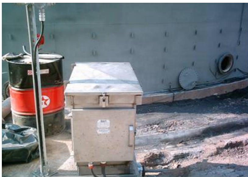
FIGURA 3.5 PUESTA EN SITIO DEL TRANSFORMADOR – RECTIFICADOR Y DEL POSTE CON LA ESTACIÓN DE PRUEBA TIPO GUAT 26 ANTIPROOF
