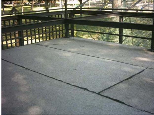
**Fotografía 14.** Membrana de Impermeabilización.
