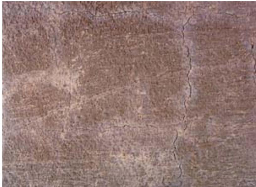
**Fotografía 6.** Fisura de afogado (fisuras en mapa)
