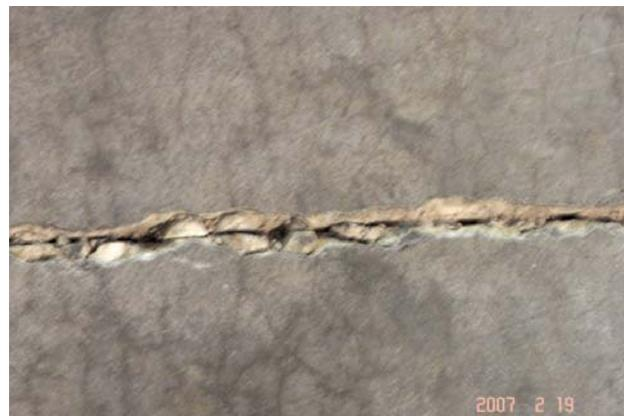
**Fotografía 8.** Fisura en la Junta de Contracción.
