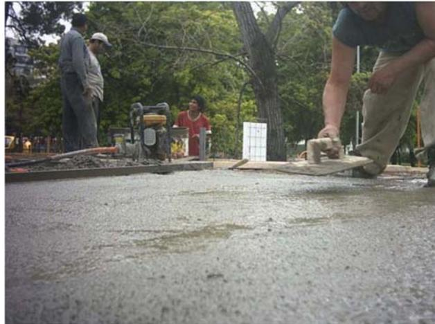
**Fotografía 12.** Fratasado de losa de hormigón.
