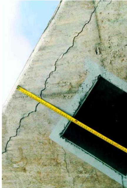
**Fotografía 2.** Fisura por corrosión de la armadura.
