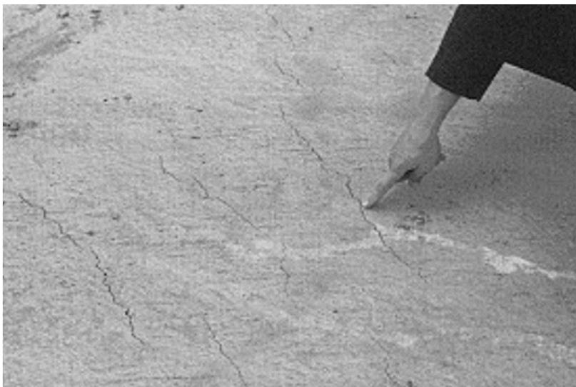
Fotografía 5. Fisura en una losa por retracción plástica
