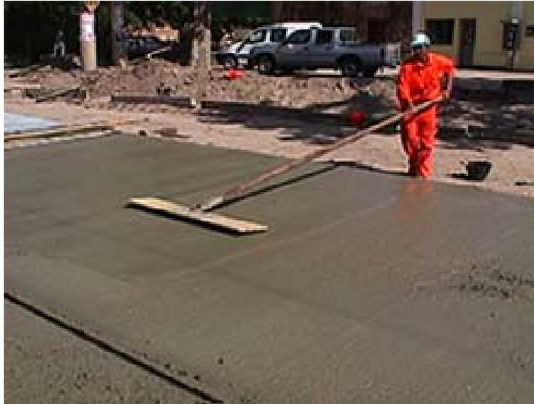
**Fotografía 13.** Acabado superficial de un pavimento de hormigón.
