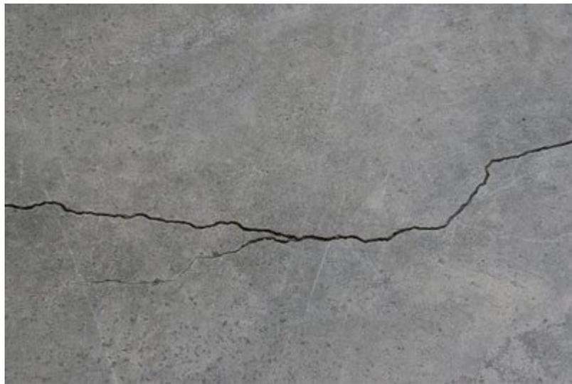
**Fotografía 1.** Grieta en una losa de hormigón
