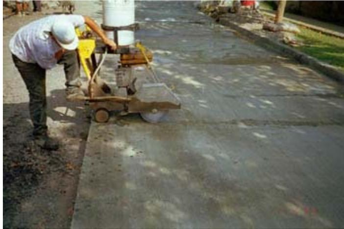
**Fotografía 9.** Aserramiento mecánico de una junta de contracción.
