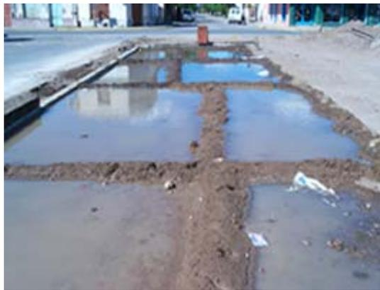
**Fotografía 10.** Losa inundada para curado
