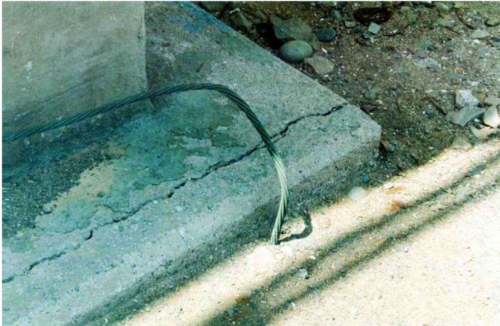
**Fotografía 3.** Fisura por corrosión de la armadura.
