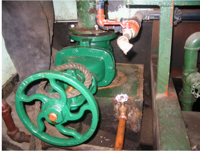
Figura 13.- Válvula de fondo
