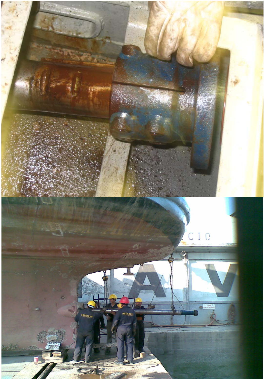
Figura 9.- Montaje de sistema de propulsión
