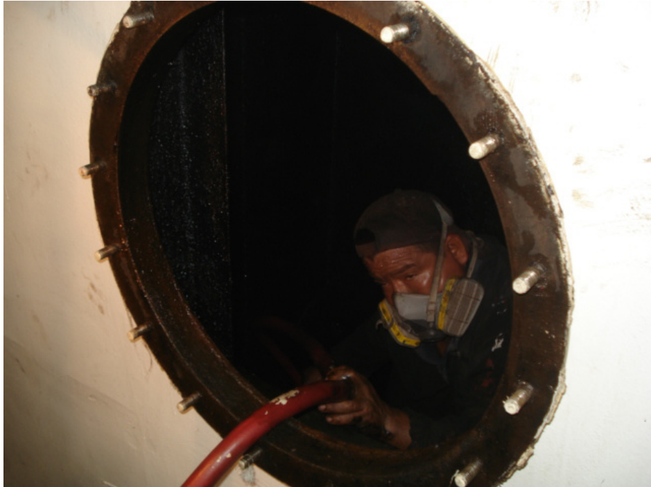
Figura 15.- Limpieza de un tanque de combustible
