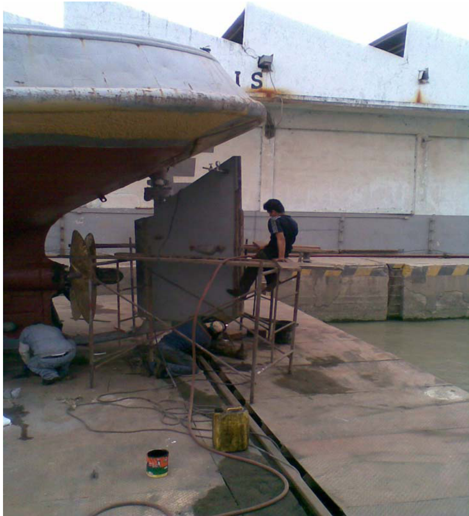
Figura 10.- Desmontaje de un sistema de gobierno
