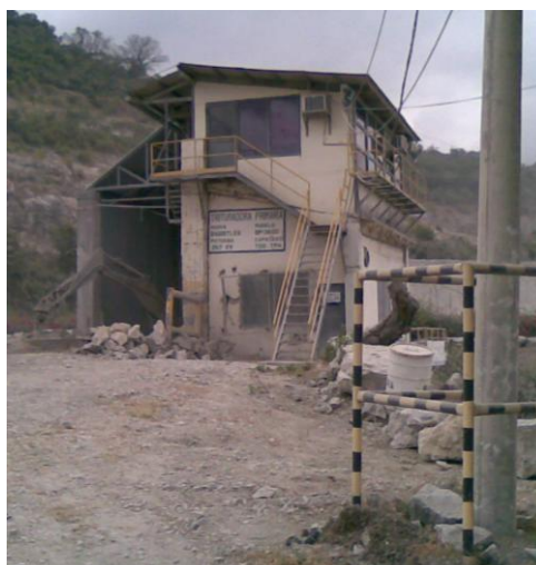
Figura # 4 Subestación "Trituración Primaria"
