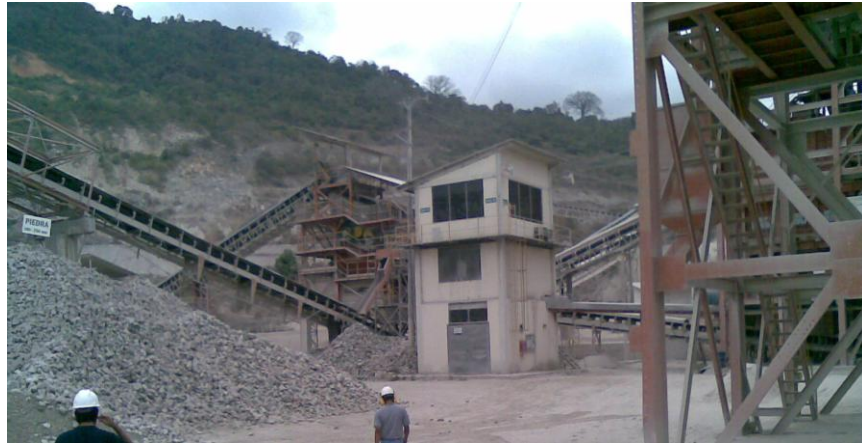
Figura #7 Subestación “Trituración Secundaria”
