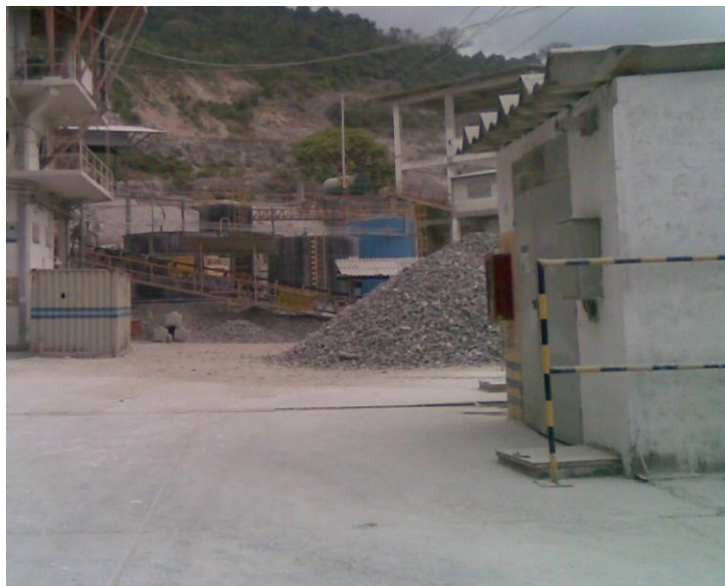
Figura #12 Subestación “Planta de Cal”
