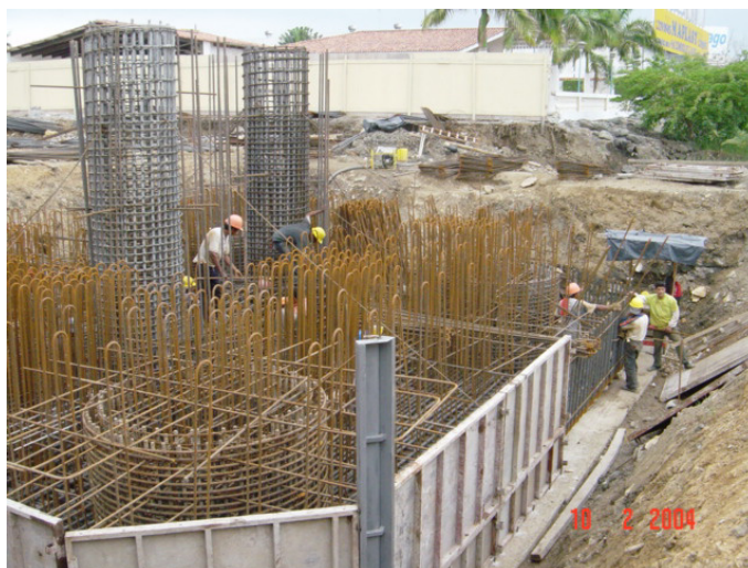
Figura 5.1.- Muestra el armadura de la zapata, parte de la sub-estructura del puente.
