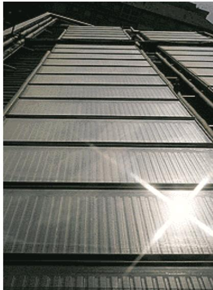
Las placas colectoras utilizan la energía del Sol para calentar un fluido portador que, a su vez, proporciona calor utilizable en una casa. El fluido portador, agua en este caso, fluye a través de tuberías de cobre en el colector solar, durante el proceso absorbe algo de la energía solar. Después, se mueve hasta un intercambiador de calor
